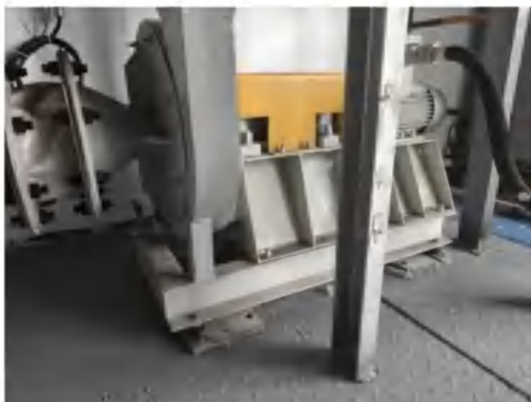
图4.3-1 噪声污染防治措施示意图（减振装置）
