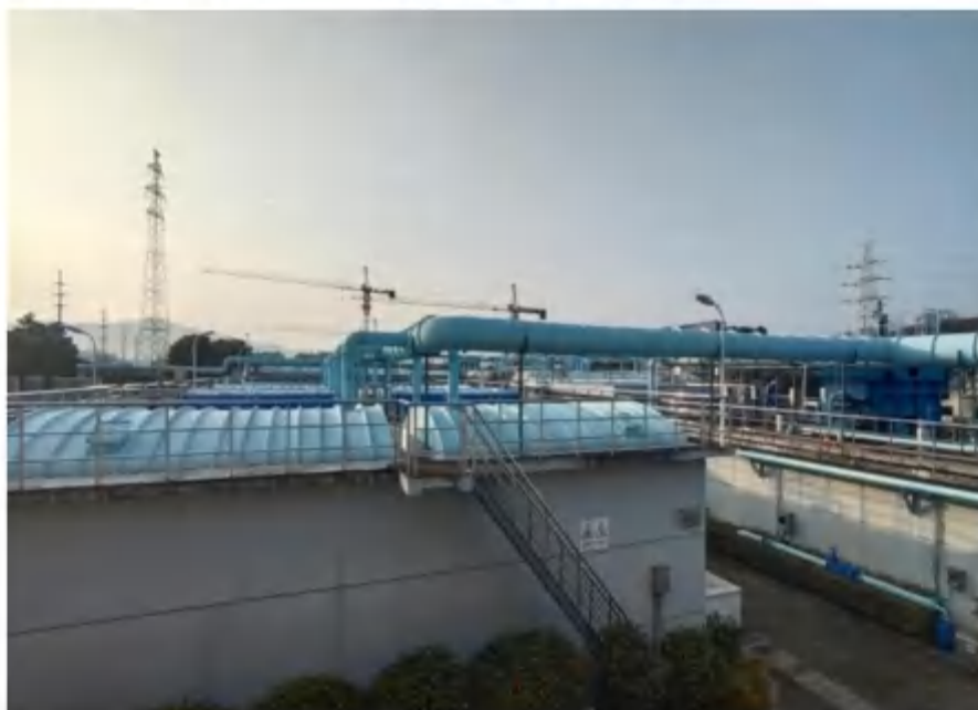
图4.1-2 污水处理站现场
