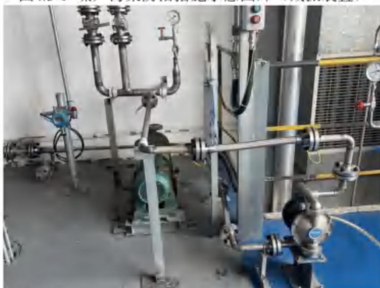
图 4.3-2 三楼水吸收塔循环气动泵及相应管道，加装金属软管及卡箍衬垫
